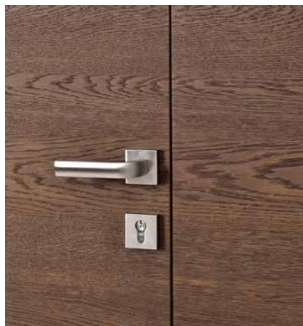
Το φύλλο της πόρτας σε πλήρη ευθεία με την επένδυση. The door leaf in line with wall covering.
